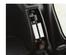
Centralna skrzynka bezpieczników za siedzeniem
